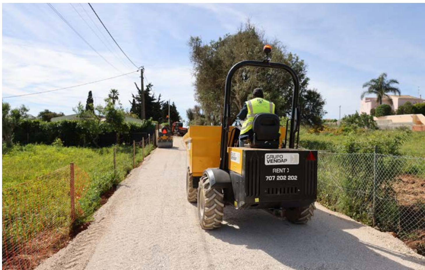
Beneficiação das ruas da Figueira, da Amendoeira e da Oliveira na vila da Luz - substituição da conduta de abastecimento de água.
