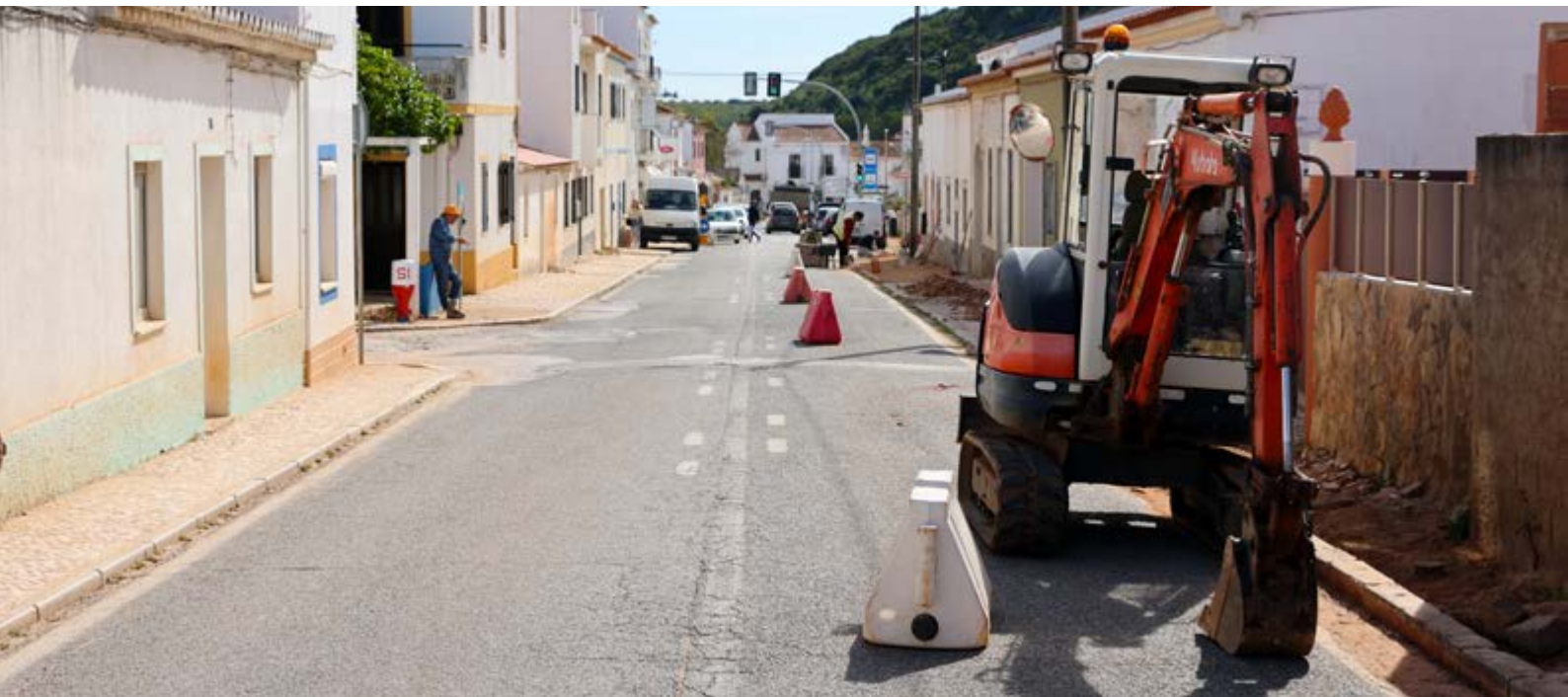
Substituição de condutas de água em Bensafrim.
