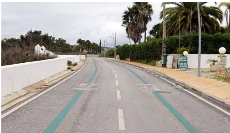
Em cima: Troço da Ecovia na Estrada da Meia Praia.
