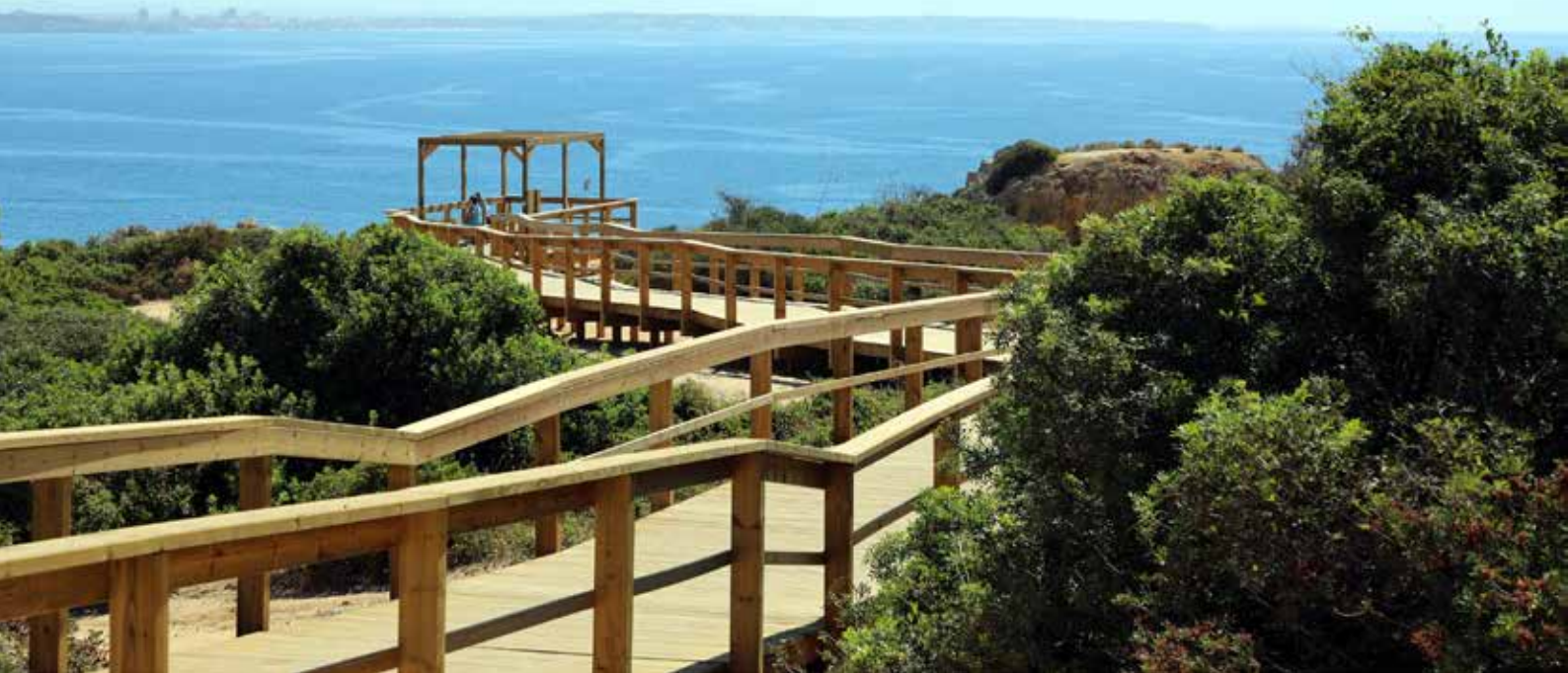
Em cima e à direita (em baixo): Passadiços construídos no âmbito da 2.ª fase de intervenção (empreitada correspondente à componente 1)
