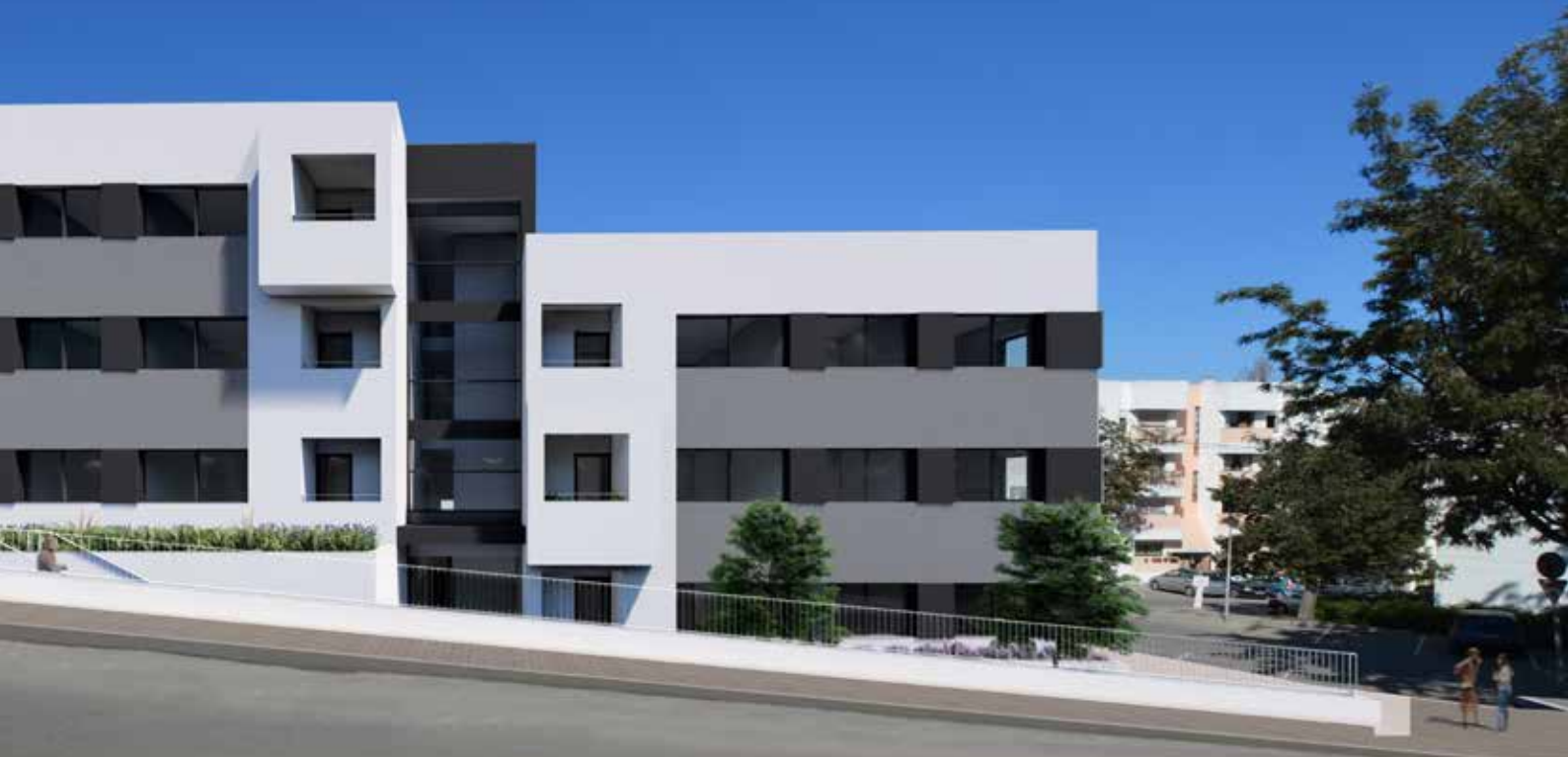
O edifício multifamiliar de custos controlados que está a ser construído no lote 14 da urbanização Chesgal é uma das intervenções previstas na Estratégia Local de Habitação.
