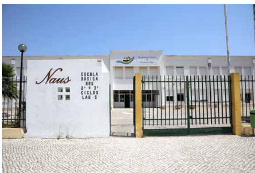
Foi aberto procedimento para a elaboração do projeto de ampliação e requalificação da Escola das Naus
