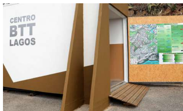
Edifício de Apoio ao Centro de BTT de Barão de São João
