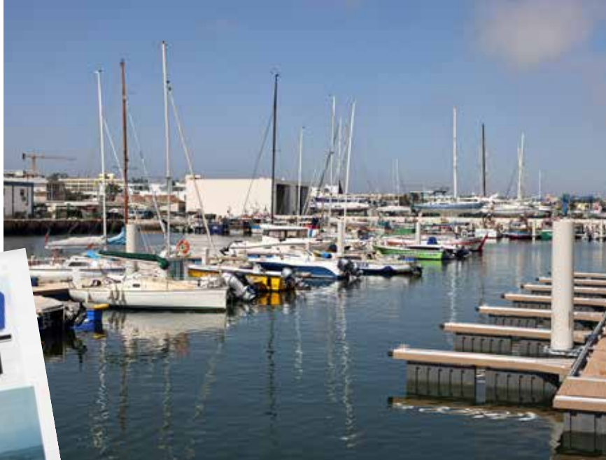
Já são visíveis os novos pontões flutuantes da área de ampliação da Marina de Lagos
