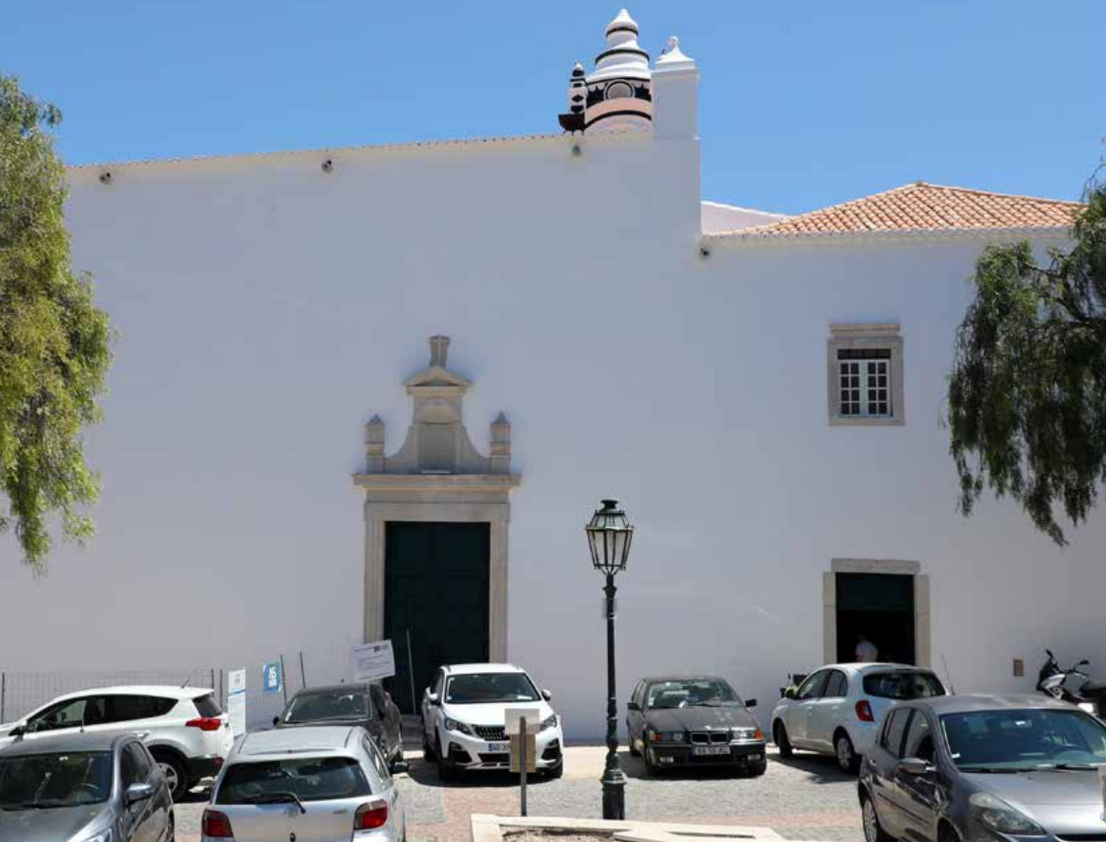
Aspetto exterior geral da “Igreja das Freiras” após a terceira e última fase de reabilitação do edifício.
