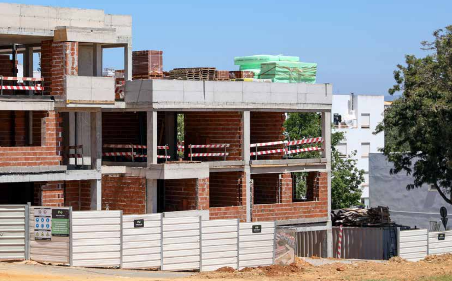
Construção, em curso, do novo empreendimento habitacional de 12 fogos (Urbanização Chesgal - Lagos)
