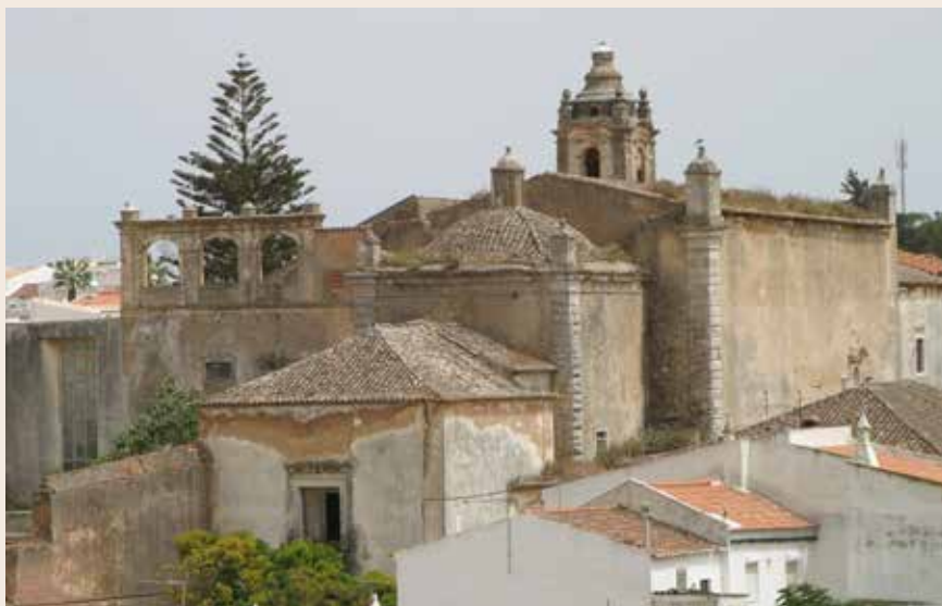
Aspeto exterior do edifício antes da intervenção
