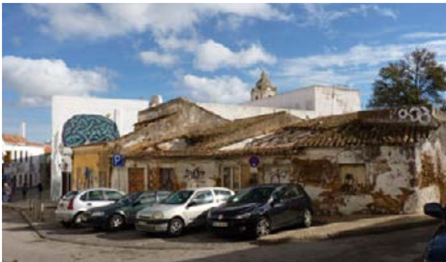
Ilustração 7. Edifícios na Rua Lançarote de Freitas
