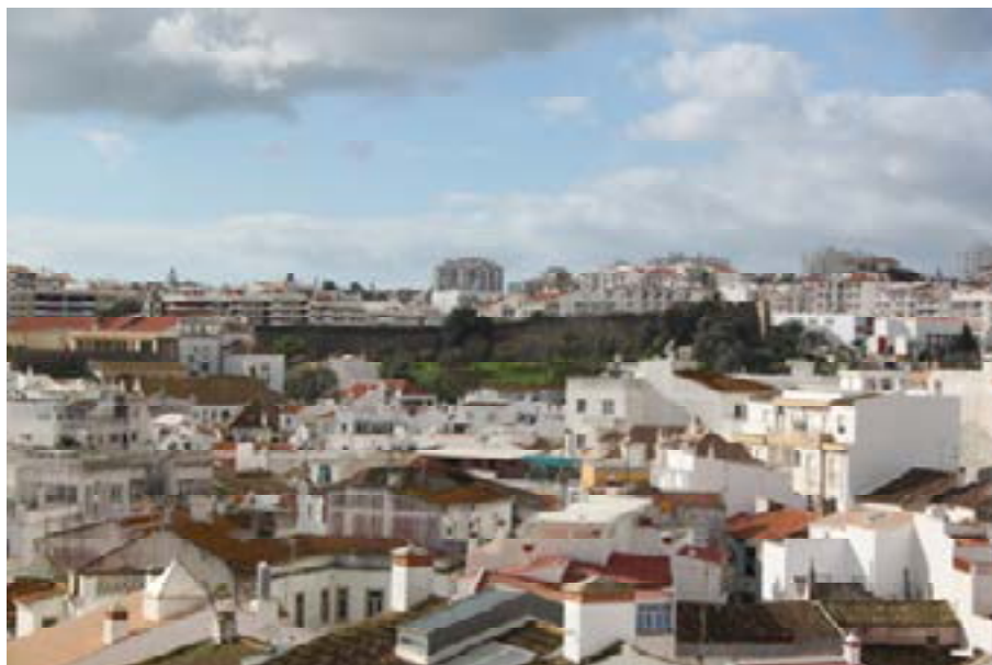
Ilustração 11. Área de Reabilitação Urbana vista da torre da Igreja de São Sebastião para o Parque das Freiras Fonte: Oficina de Arquitectura, março de 2014
