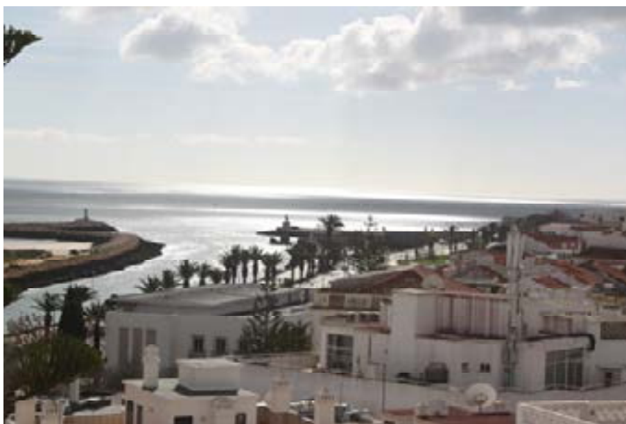
Ilustração 2. Vista da Igreja de São Sebastião sobre a Área de Reabilitação Urbana e sobre o mar
