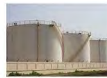
Tanques de armazenagem
